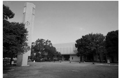
バロー文化ホールの外観
