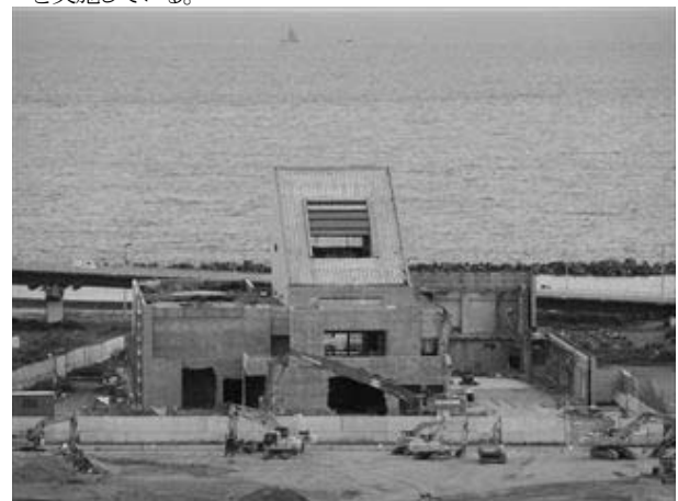
石巻文化センターは震災で津波の直撃を受けて1階がほぼ壊滅。同様の被害を受けた石巻市民会館と合わせた形で複合文化施設として再建されることとなり、取り壊された。
