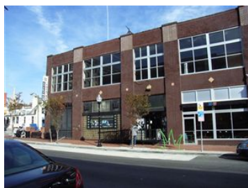
エブリマン・シアターの外観
