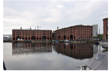
テート・リバプールの開設されたアルバート・ドックの旧港湾施設
